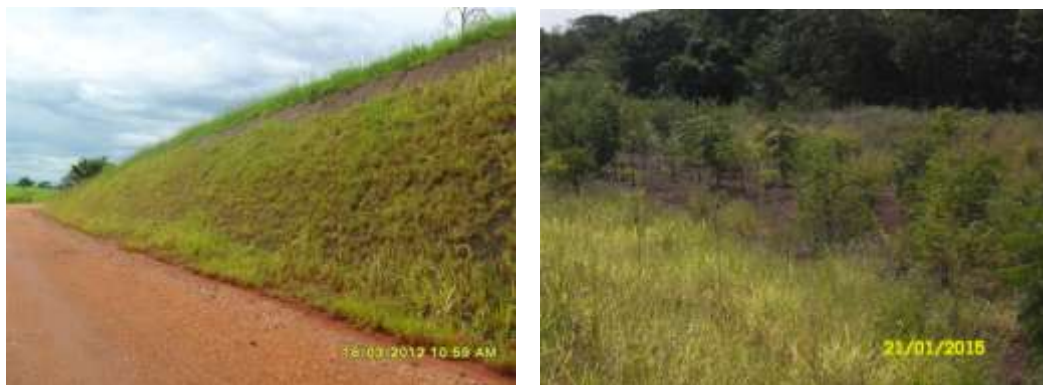
Figura 09: área após recuperação implantada no local.
